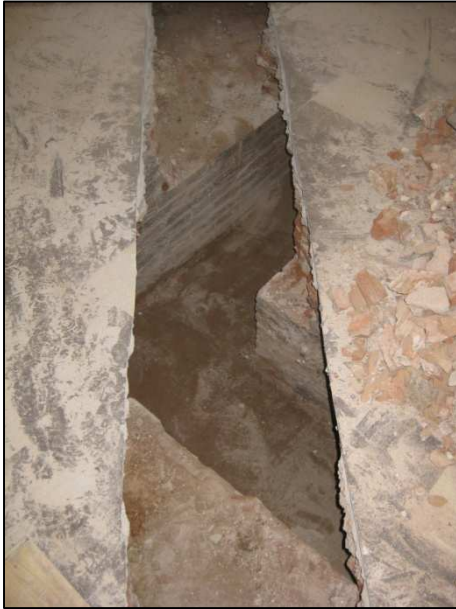
FOTO 5. Detall de la claveguera UE 09 (rasa 4).
