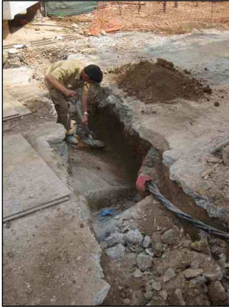
FOTO 1. Treballs de realització de la rasa 1.
